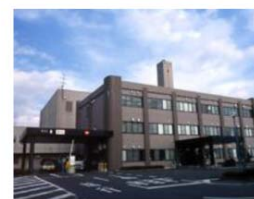
新治地方広域事務組合 環境クリーンセンター
