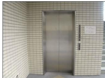
(例) エレベーター
